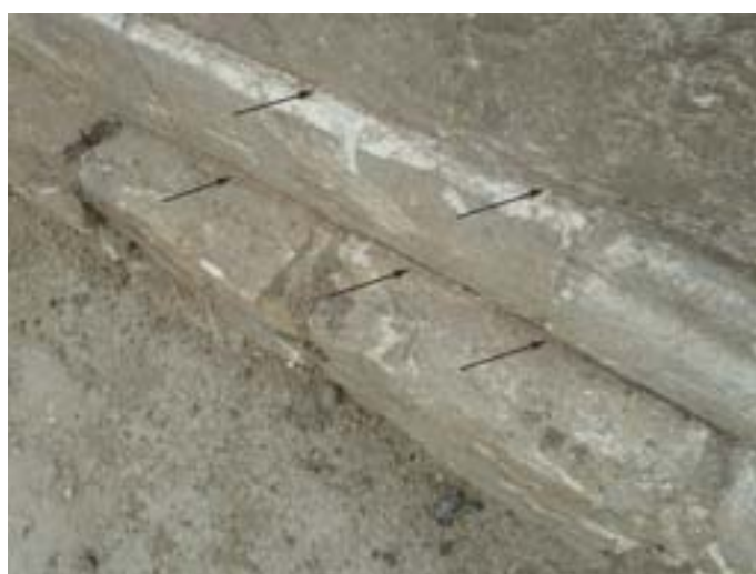
Afb. 5.44 Detail van de westzijde van de fundering van de westelijke muur.
