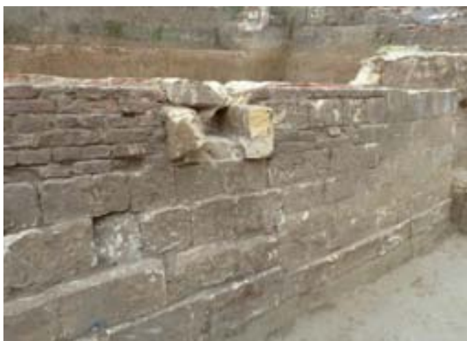
Afb. 5.65 Detail noordelijke beschoeiing vijver gezien vanuit het zuiden.
