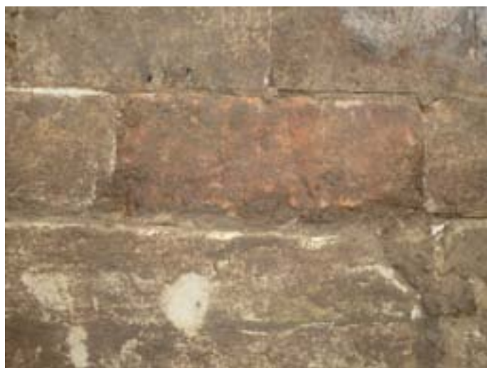
Afb. 5.54 Detail noordzijde van de noordmuur.
